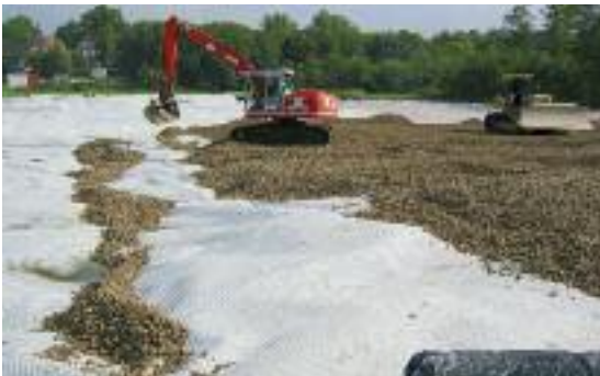
Полагане на минерален пласт с дебелина мин. 200mm
