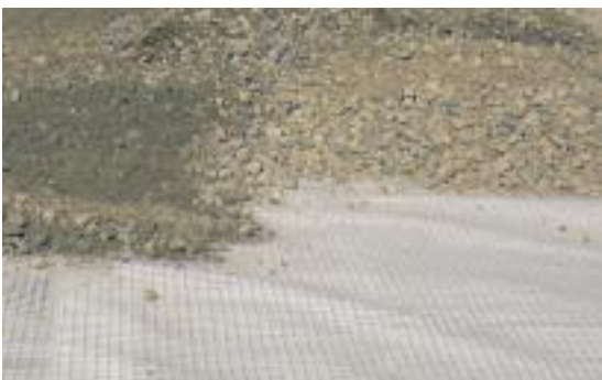
Защепване с материала от минералния пласт
