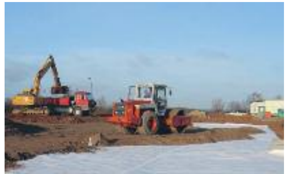
Уплътняване на почвата над Combigrid®
