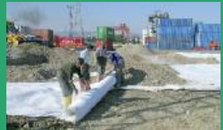
Фиг. 5 Разгъване и препокриване на Combigrid® над меката земна основа
