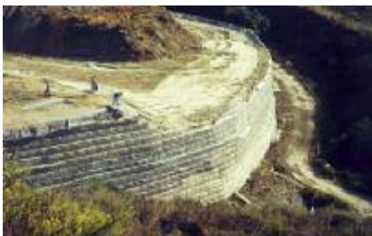
Механизирано стабилизиране на почвата на стенна конструкция
