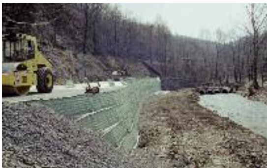
Стабилизиране на железопътен склон
