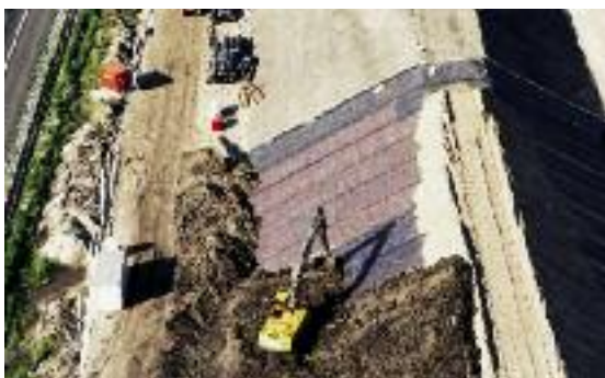
Укрепване на склона на шумова бариера чрез Secugrid®
