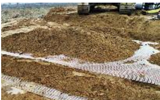
Два слоя Secugrid® за укрепването на пътя, използван и като дига
