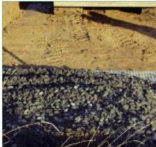
Фиг. 17 Пологане на основен пласт чакъл върху Secugrid®
