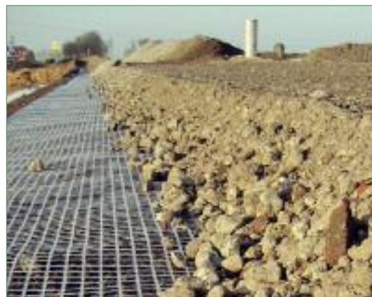
Фиг. 19 Трошен камък върху Secugrid® за стабилизиране на пътната основа на подходящи пътища
