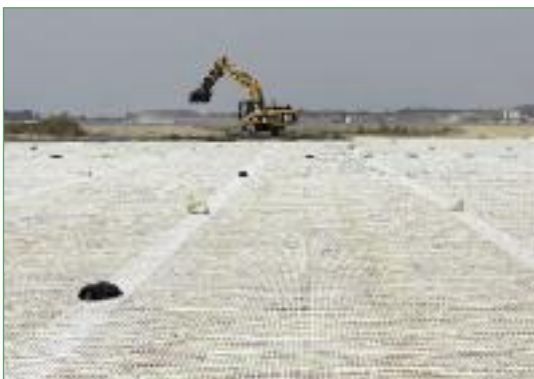
Фиг. 7 Положена геомрежа Secugrid® като укрепващ пласт на пътната основа.
